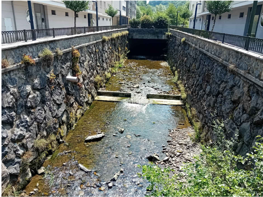
Foto g: Vistas de los muros de encauzamiento existentes aguas arriba y aguas abajo del azud Plastificado 3 (XDEBANT001340000). Aguas arriba se aprecia el puente existente sobre el azud Plastificado 4
