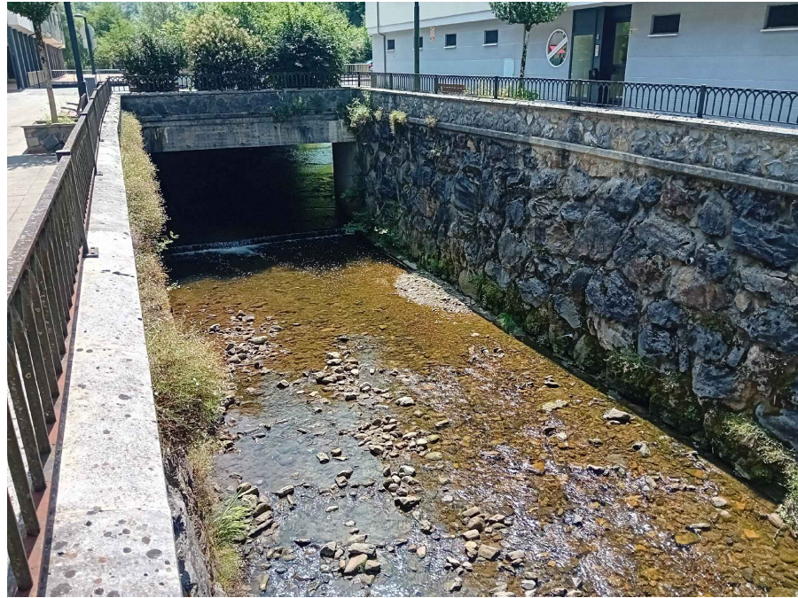
Foto i: Vista de los muros de encauzamiento existentes aguas abajo del azud Plastificado 4 (XDEBANT001580000). Aguas arriba se aprecia el puente existente sobre el mismo azud.
