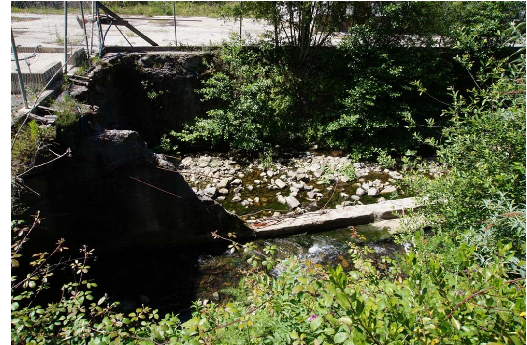
Fotografía-5: Murete prolongación de la tajamar de la obra de paso. Demolición completa.
