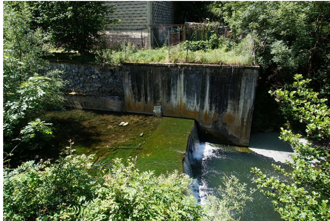
Fotografía-4: Vista del Azud-4 desde la margen derecha. Demolición completa respetando 1 m de ambos estribos.
