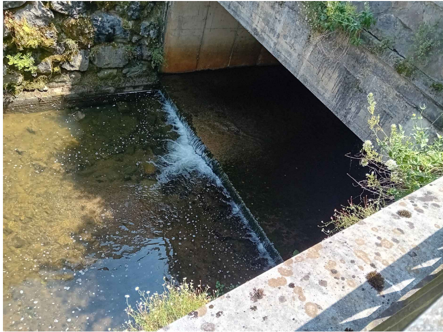
Foto h: Vista del azud Plastificado 4 (XDEBANT001340000). Aguas arriba del azud se aprecia que el lecho del cauce de la regata pasa a ser de hormigón.
